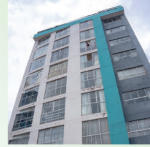
Residencial Calicanto Fideranda 2014
